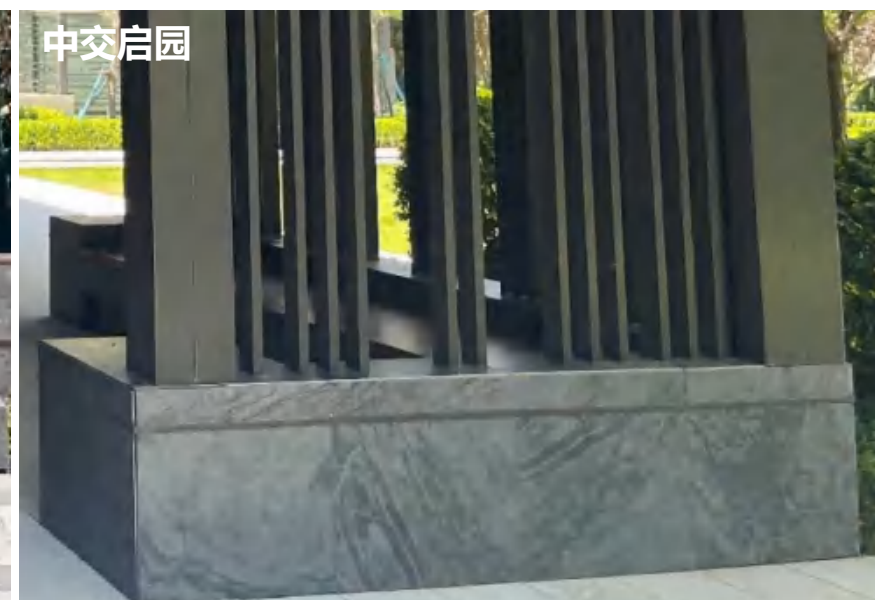
平面铺装与立面交接部位的留缝小于5mm
