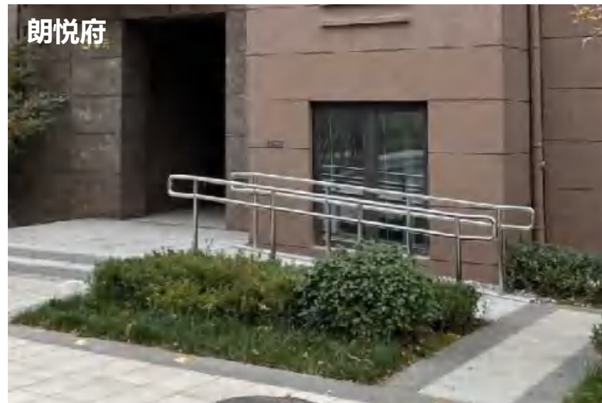
无障碍坡道设置上层和下层双层扶手
