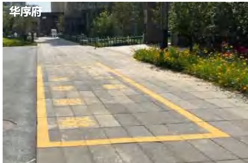
消防登高操作场地采用抗压性铺装材料
